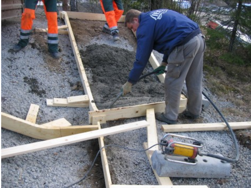
Figur 15 Utlegging og vibrering av betongen
