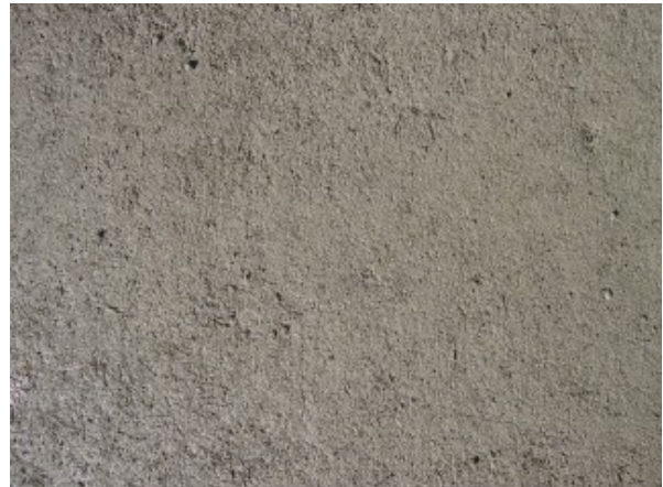
Figur 19 Overflate etter avretting med rettebrett
