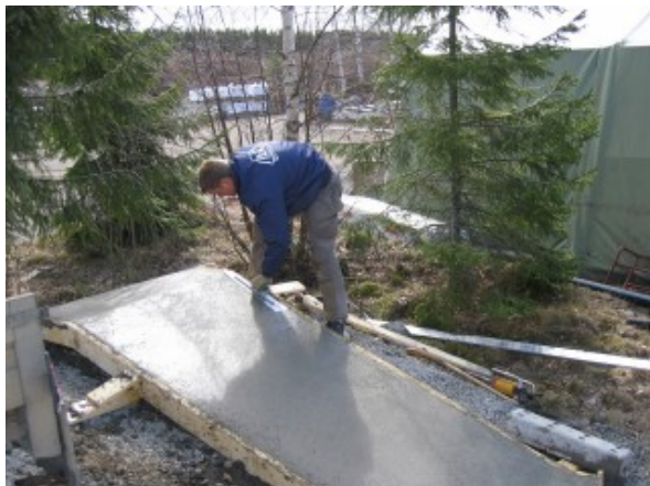
Figur 20 Finglatting med stålsverd
